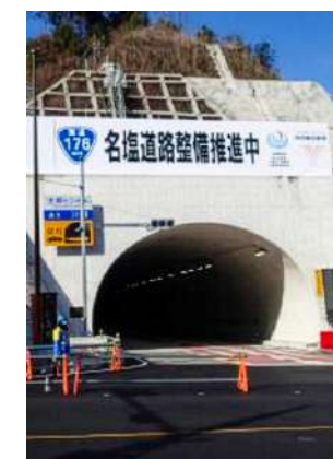
国道176号(名塩道路)の 生瀬トンネルが遂に開通、全線開通 までもう一歩に(2024.2)
